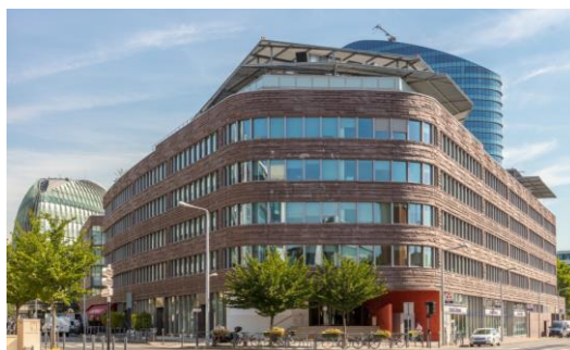
GALEO & DUEO ILM1 (92) - SCI GALEO & DUEO ILM1 gérée par Primonial REIM France
